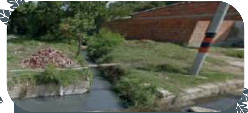
Carrera 9 entre calles 60 y 61 (arroyo sin canalizar)
