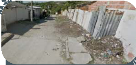
Calle 64 b con carrera 9 k (calle sin pavimentar)
